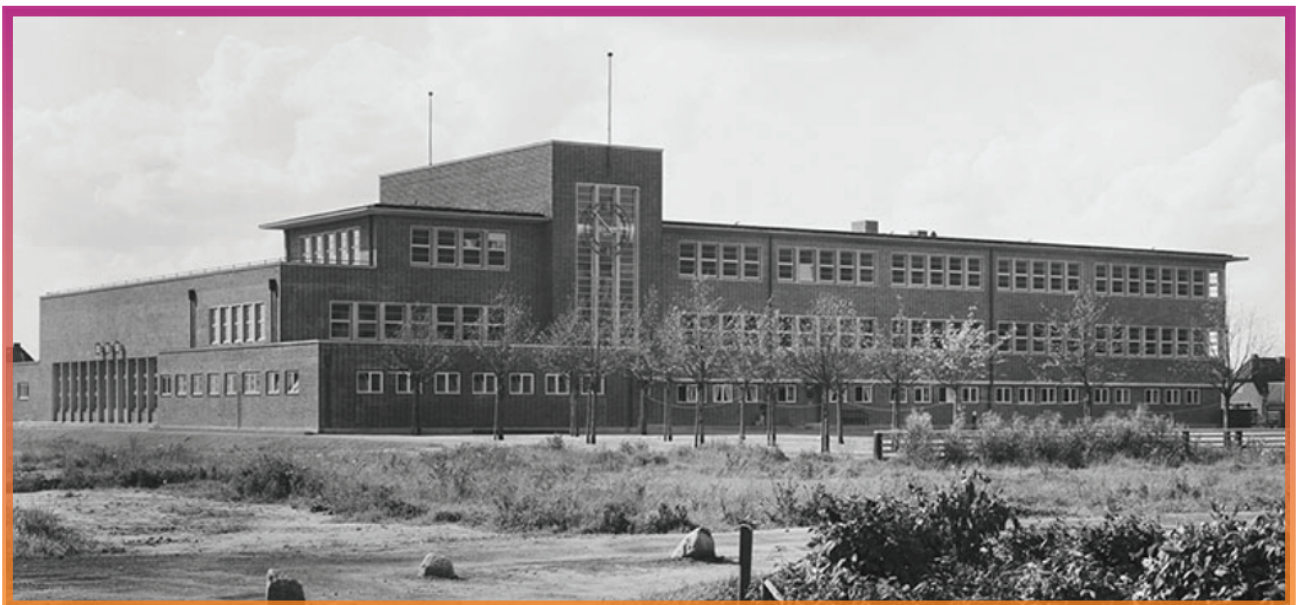
Abb.: Die Schule Berne kurz nach ihrer Fertigstellung 1929. Typisch für Schumacher-Bauten sind die lichtdurchfluteten Räume mit den großen Fensterfronten.
